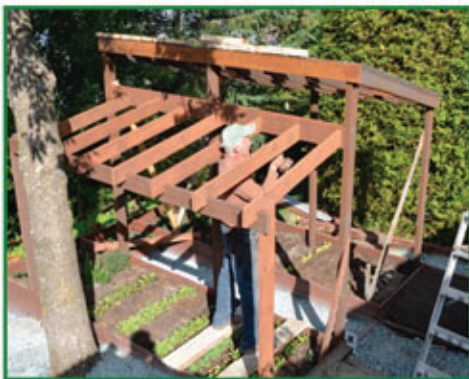
Assemblage du toit section gauche
