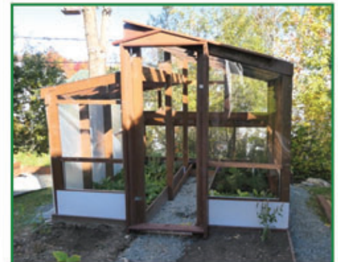
Finition, pose des vitres et calfeutrage. L'installation de l'électricité et l'eau est facultative, mais très utile.
