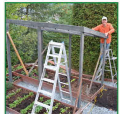
Début de l'assemblage de la structure principale et du toit section droite.
