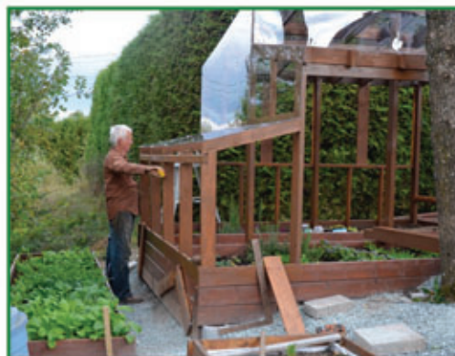
Pose du LEXAN sur les toits
